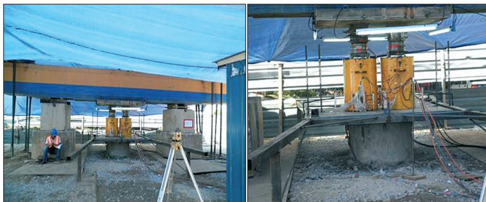
■ [Figuras 7a y 7b] .- Prueba de carga (Izda.) y detalle de la auscultación de la cabeza del pilote durante la prueba de carga (Dcha.).
