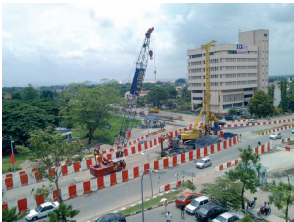
■ [Figura 1] .- Vista de la obra en Alor Setar (Kedah, Malasia).
