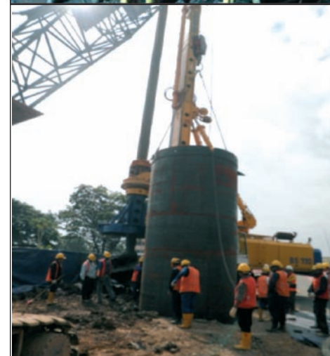
[Figura 5] .- Instalación de la armadura y clavado del tubo guía.
