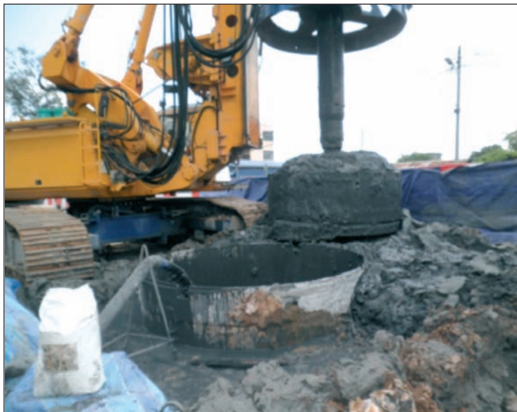
[Figura 4] .- Con los polímeros del Sistema G3 ® de GEO, se consiguen mejores excavaciones por una mayor concentración de los sólidos.
